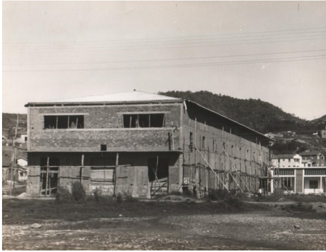
Construção do Cine De Lourdes
