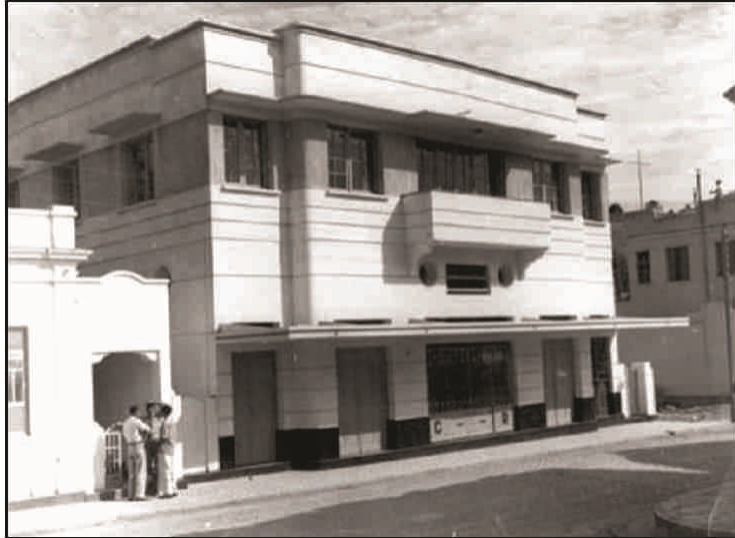
Fachada do Cine Renascença, 1952.
