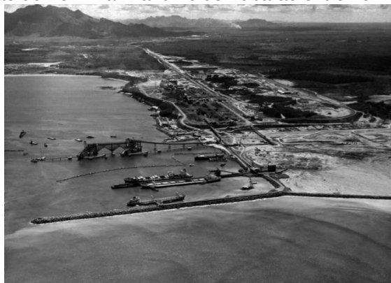
FIGURA 06: Implantação do Terminal Marítimo de Tubarão entre 1971 e 1972.
