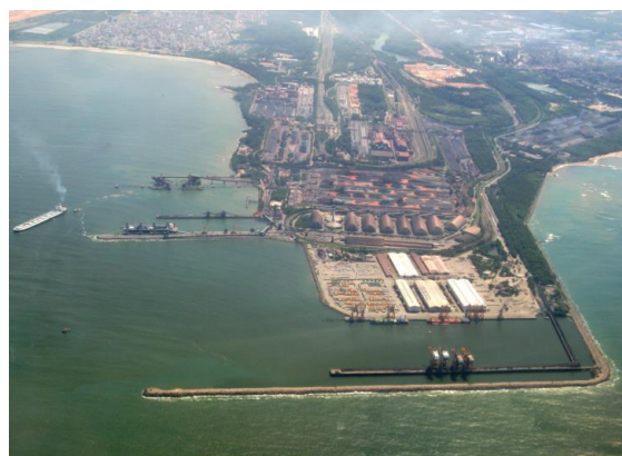
FIGURA 07: Configuração do Terminal Marítimo de Tubarão na década de 2012 após obras de expansão.
