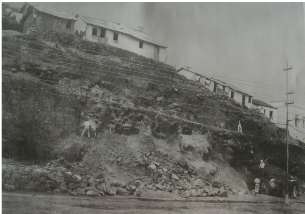
Figura 10 – Obras na avenida Duarte Lemos, na altura da Santa Casa de Misericórdia e da rua São João, em 1924
