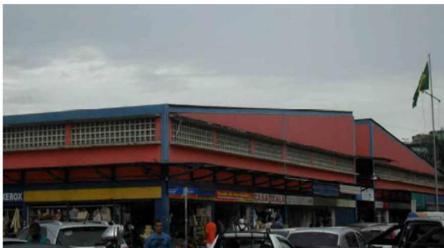
Figura 7 – Vista lateral dos atuais galpões do Mercado da Vila Rubim
