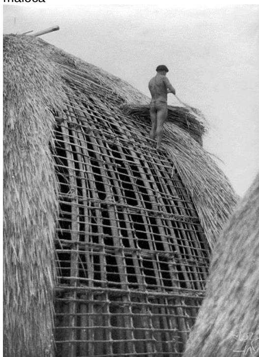
Fotografia 1 - Indígena kuikuro construindo maloca
