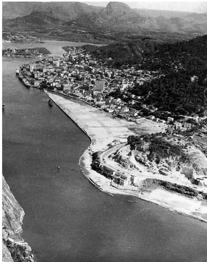
**Foto 11 – Execução das obras de construção do aterro da Esplanada Capixaba. Fonte: Acervo IJSN.**
