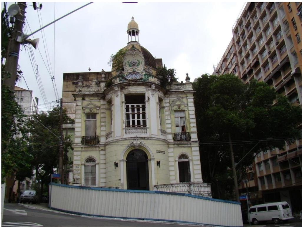
**Foto 15 Antigo Palácio Domingos Martins com suas obras paradas. Centro de Vitória. 2010. Fonte: Autor. (Cabe destacar a degradação física da fachada do prédio e, além disso, o crescimento de vegetação no teto como sinais mais evidentes do abandono).**
