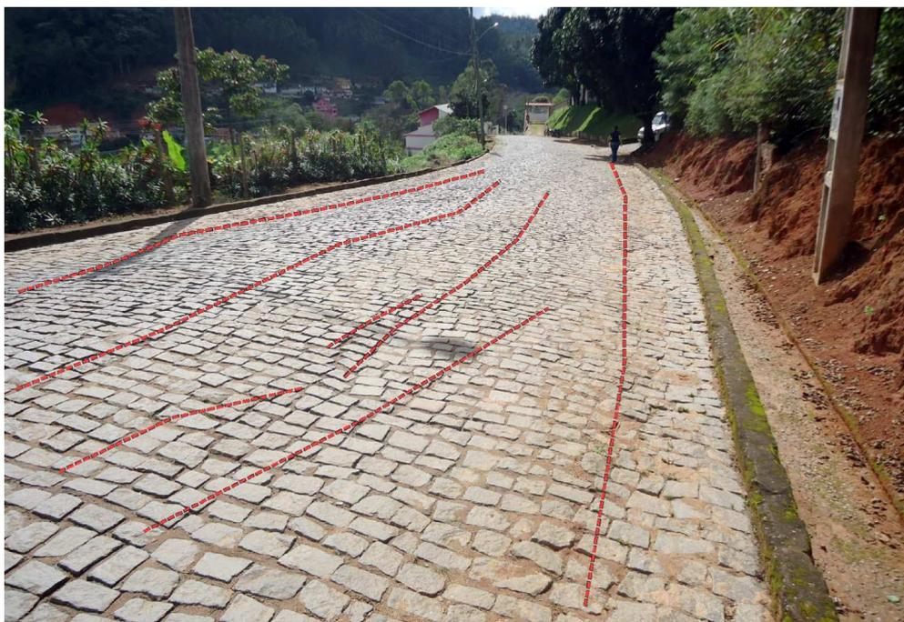
**Figura 12** – As linha vermelhas indicam os pontos de deformção do pavimento ao longo do qual foi efetuada a varredura com o GPR. Do lado direito da imagem o corte do talude em estudo.
