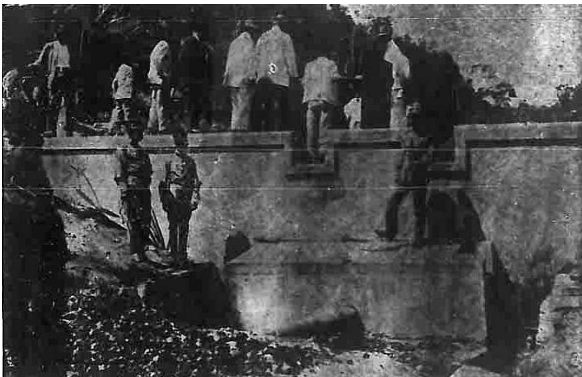
Figura 4: Tanques de filtragem sendo construídos na captação do rio Pau Amarelo, 1909. Fonte: Arquivo Público Estadual.
