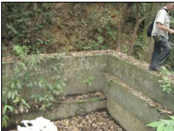
Figura 6: ruínas do antigo sistema de decantação, Rebio Duas Bocas, 2010.
