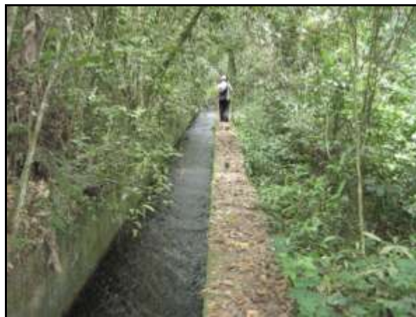
Figura 7: curso atual do rio Pau Amarelo cobrindo a antiga passarela dos operadores da represa.
