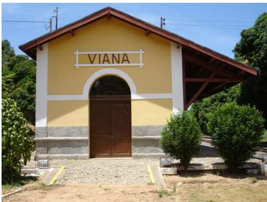
Anexo 3.2. Estação de Viana: atualmente restaurada.
