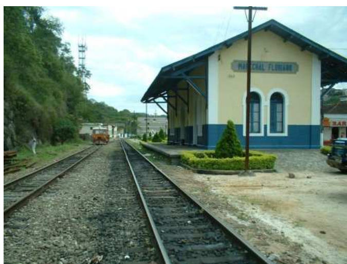
Anexo 3.4. Estação de Marechal Floriano: atualmente restaurada.
