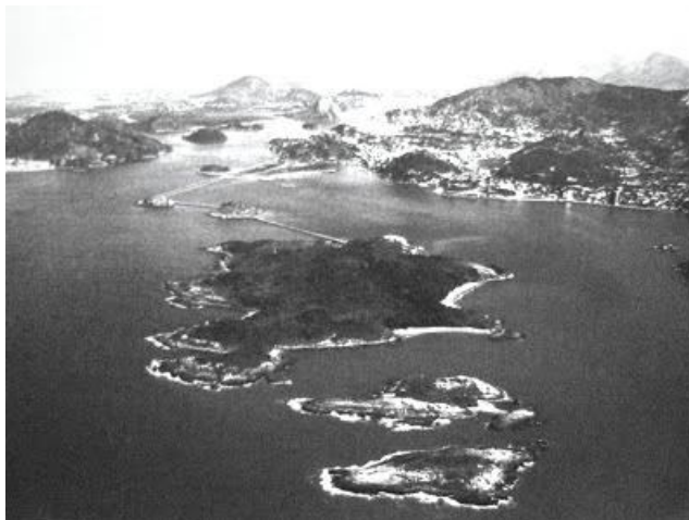
Figura 1.11 - Enrocamento de acesso à Ilha do Boi. 1960.
