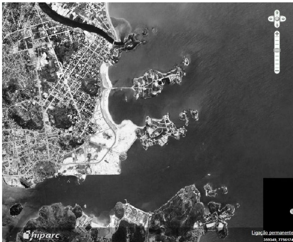
Figura 1.9 – Foto área da região após o aterro. 1978. Fonte - HIPARC GEOTECNOLOGIA, 2013.
