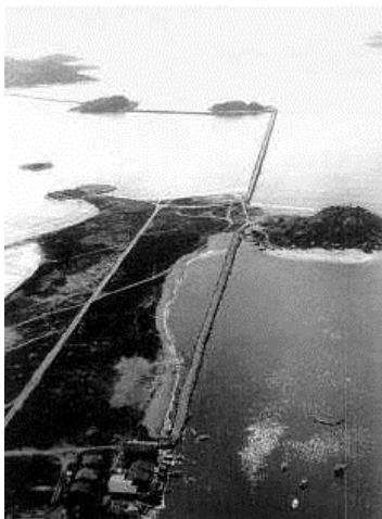
Figura 1.10 - Enrocamento de acesso às Ilhas do Bode, Sururu e Boi. 1950.
