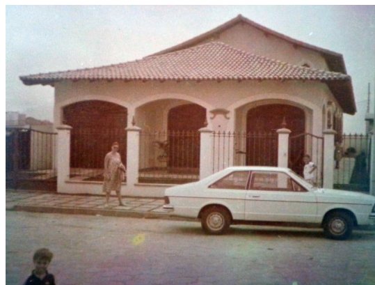
Figura 2.5 - Obra concluída de uma das primeiras residências da Enseada do Suá.
