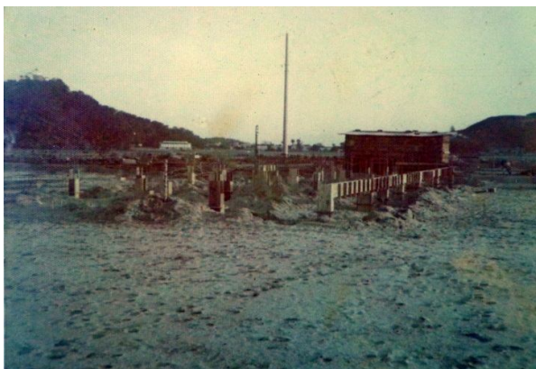
Figura 2.4 - Obra de uma das primeiras residências da Enseada do Suá.
