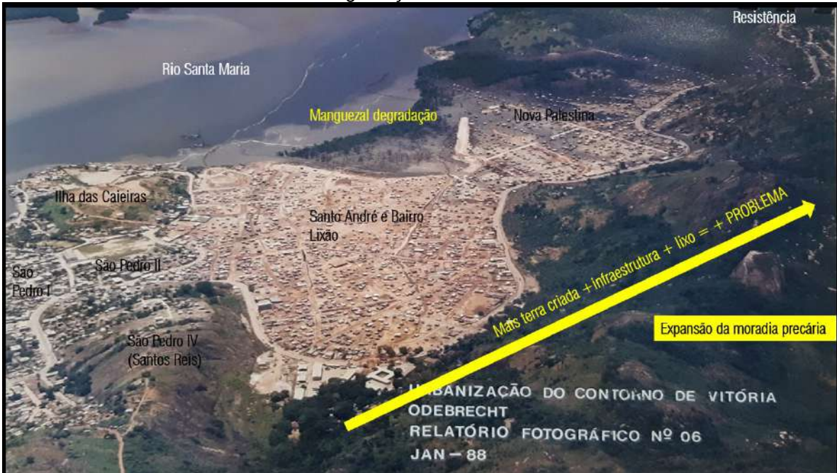
Figura 119 - Obras de aterro em janeiro de 1988 avançam: expansão da moradia precária e degradação ambiental.
