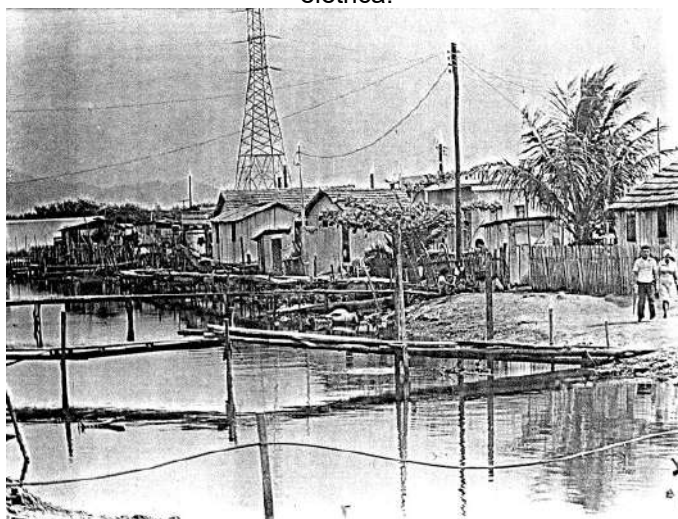
Figura 89 - Maria Ortiz (Lixão de Goiabeiras) – ocupação sob as torres de alta tensão de energia elétrica.
