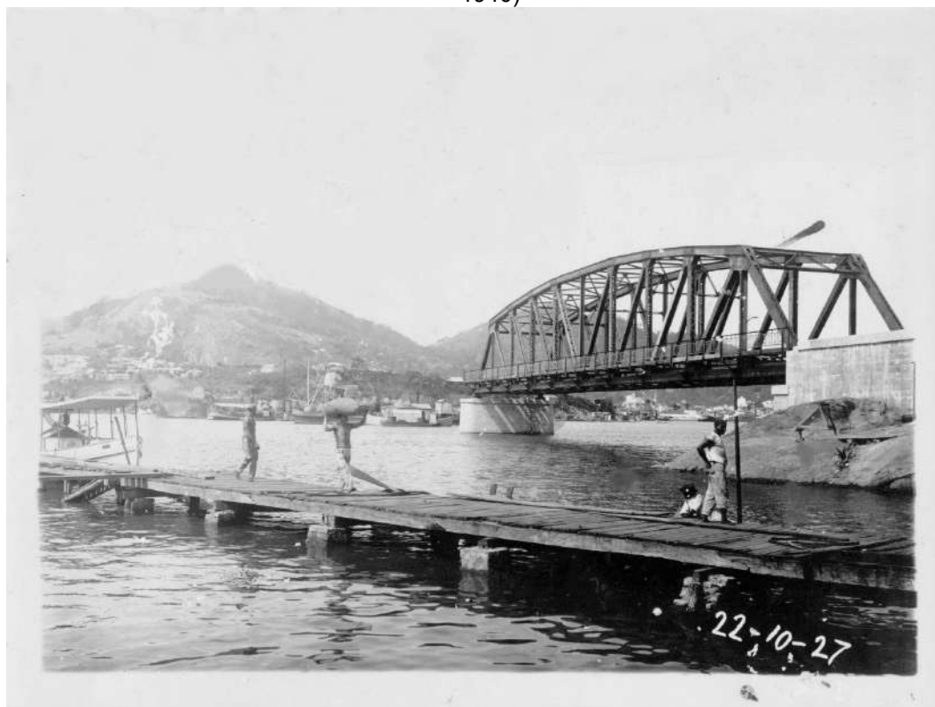
Figura 61 - Ponte Florentino Avidos: ligação da Ilha de Vitória aos municípios de Vila Velha e Cariacica, passando pela Ilha do Príncipe, em 1927 (1) e após concluída (data provável década de 1940)
