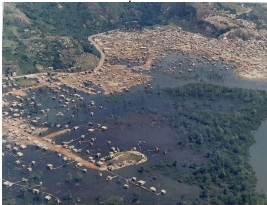
Figura 116 - Obras de aterros contratadas pela PMV nos bairros Santo André, São Pedro e Lixão, março/1987.
