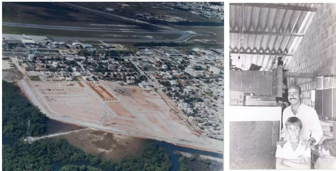
Figura 96 - Casas populares em execução sobre aterro argiloso sobre área alagável às bordas do manguezal (1) e Prefeito de Vitória em 21/01/1987 em visita a uma das casas entregues. Pela imagem, verifica-se a baixa qualidade arquitetônica da unidade habitacional (2).
