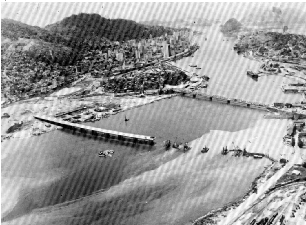
Figura 75 - A 2ª ponte em construção sobre o aterro executado sobre a área da Favela da Maré, década de 1970.
