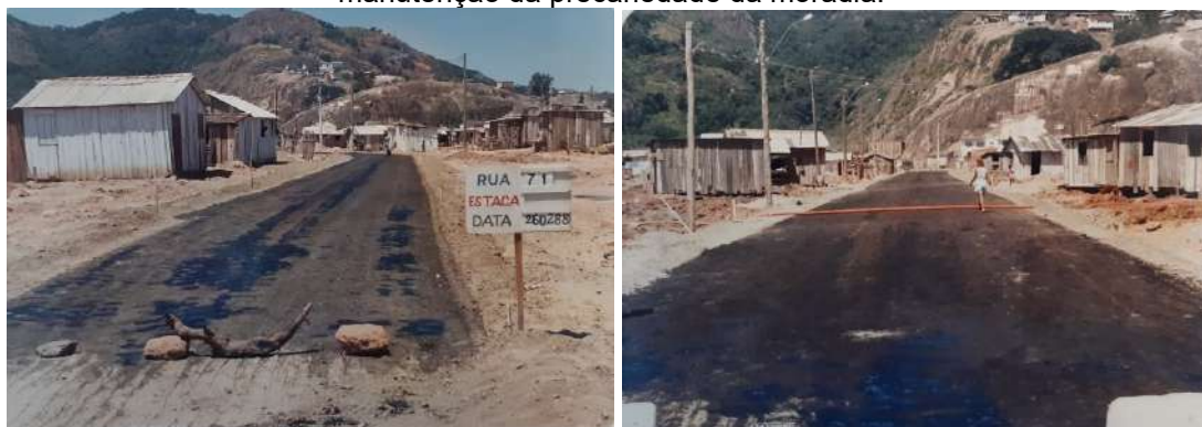
Figura 120 - Obras de asfaltamento em 25 de março de 1988 – a infraestrutura executada em meio à manutenção da precariedade da moradia.
