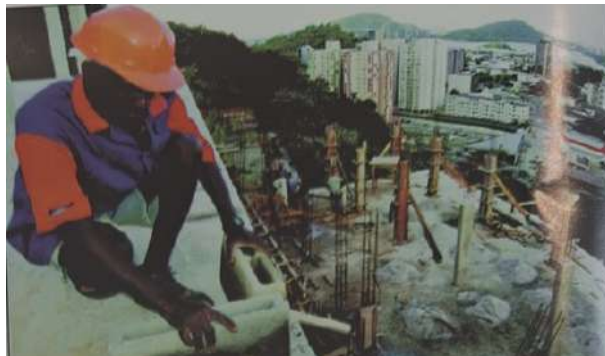
Figura 142 - Unidades habitacionais do Jaburu sendo construídas – o Projeto Terra vencendo a dificuldade de construir sobre altas declividades.
