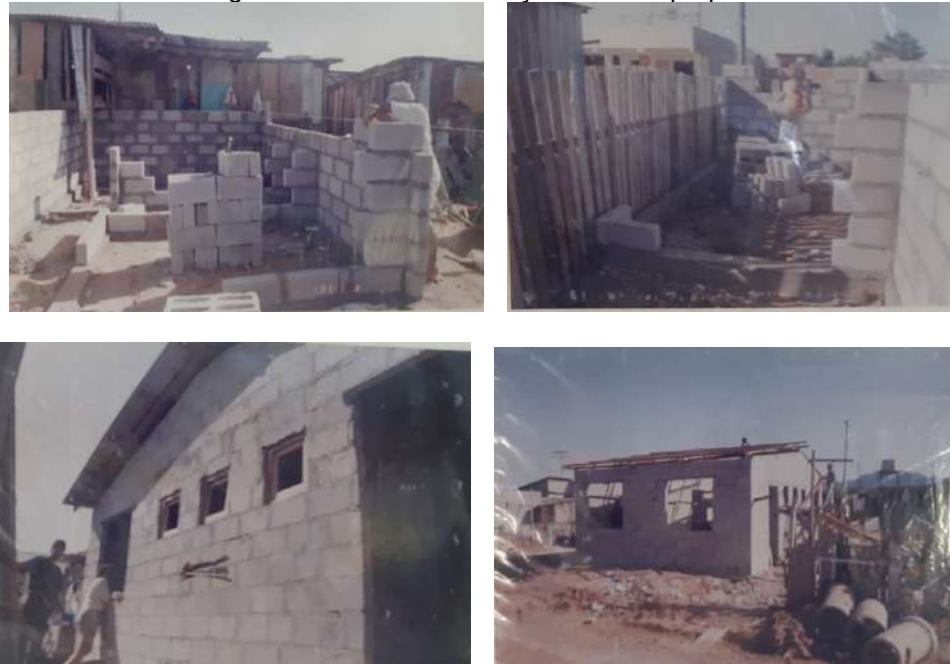
Figura 136 - a autoconstrução da casa própria
