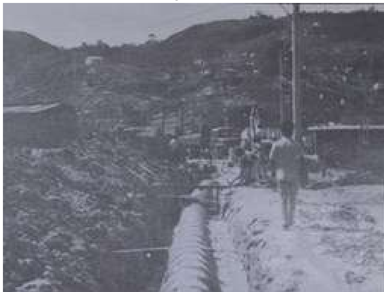
Figura 105 - São Pedro e as obras de urbanização do PROMORAR contendo aterro, drenagem e iluminação pública – vê-se ao fundo a Ilha das Caieiras.
