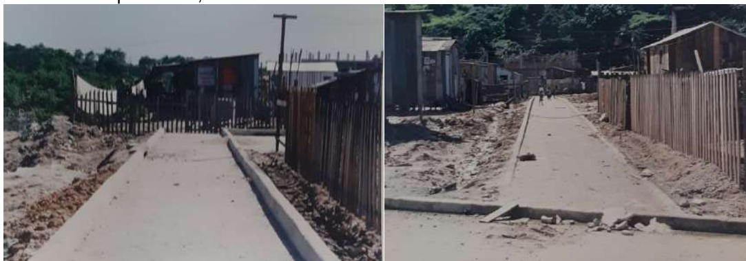
Figura 126 - Nova Palestina no final das obras da 2ª fase do Projeto em novembro 1992: ruas de pedestres, infraestrutura e a velha forma de morar em barracos.
