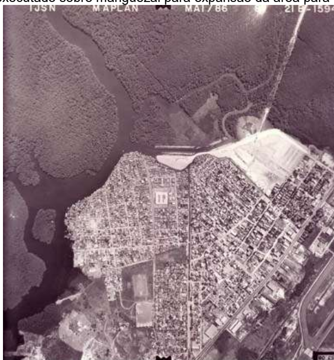
Figura 94 - O aterro executado sobre manguezal para expansão da área para novas moradias, 1986.
