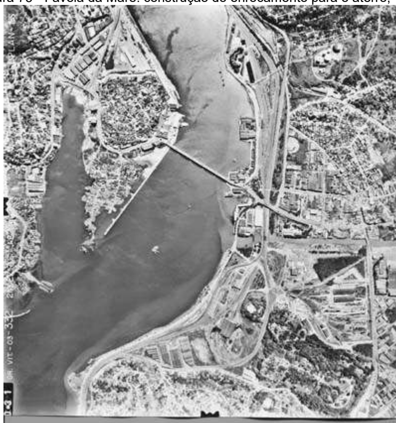
Figura 73 - Favela da Maré: construção do enrocamento para o aterro, 1970.
