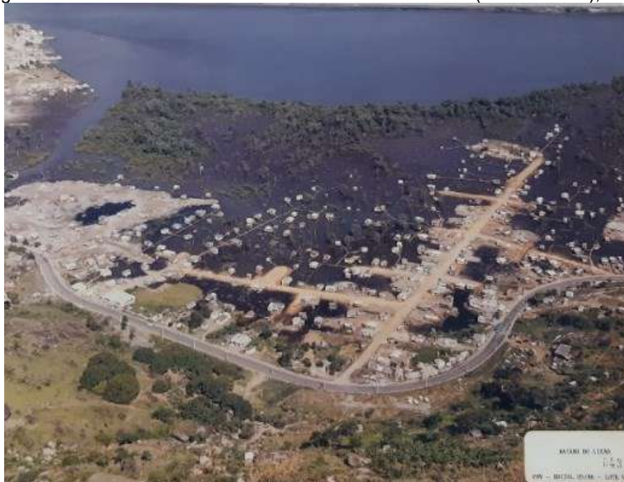
Figura 118 - Obras de aterro no bairro Lixão e Santo André (São Pedro III), 1987.
