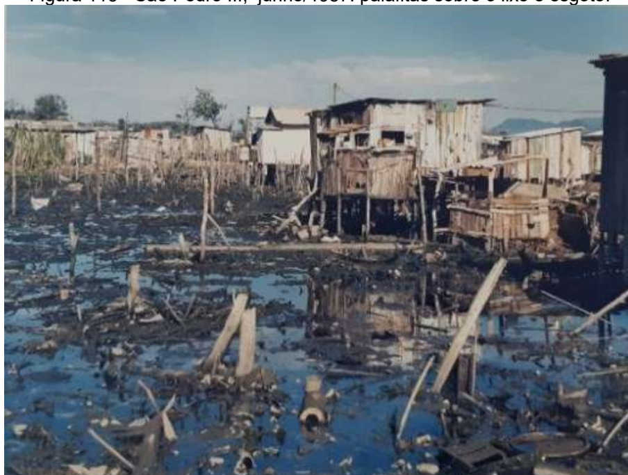
Figura 113 - São Pedro III, junho/1987: palafitas sobre o lixo e esgoto.
