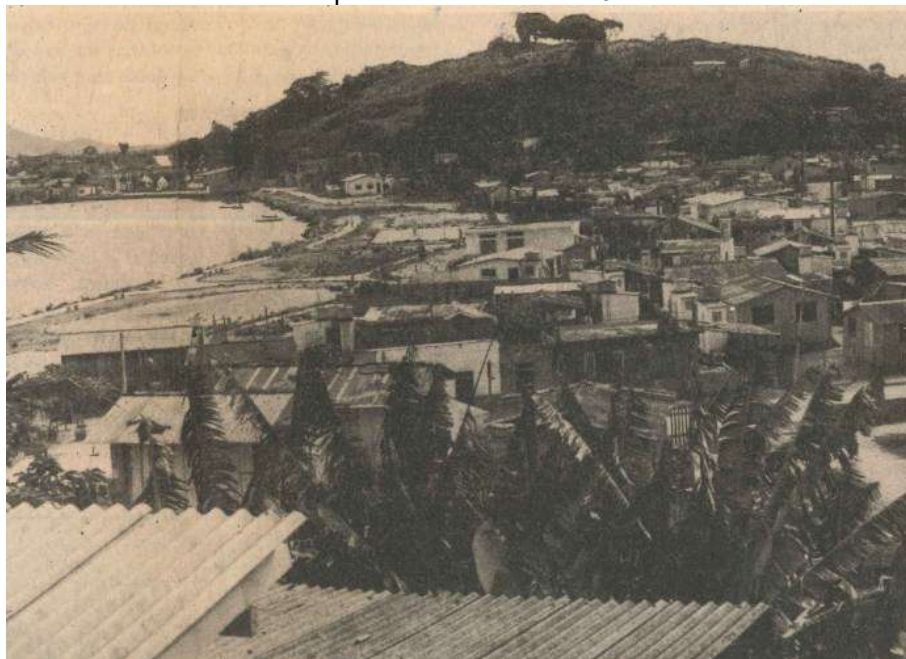
Figura 108 - São Pedro I (1985) com a Ilha das Caieiras ao fundo – Barracos com as unidades sanitárias construídas pelo Promorar sobre 494 lotes urbanizados.
