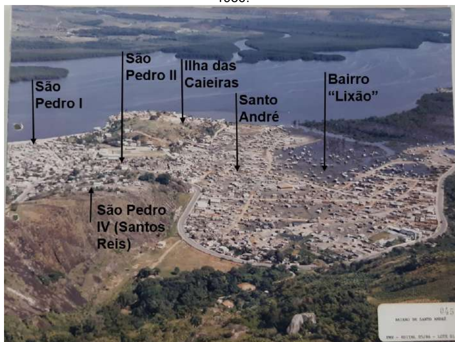
Figura 115 - Obras de aterros contratadas pela PMV nos bairros Santo André, São Pedro e Lixão, 1986.
