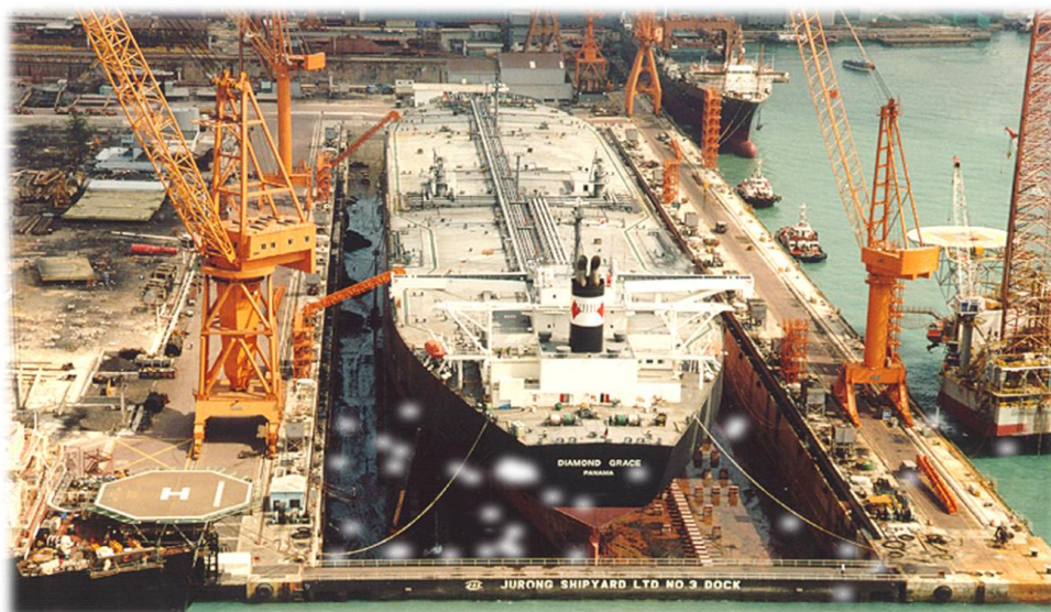
Figura 26: Estaleiro gêmeo da futura construção. Fonte: Reunião de avaliação Aracruz 290310.
