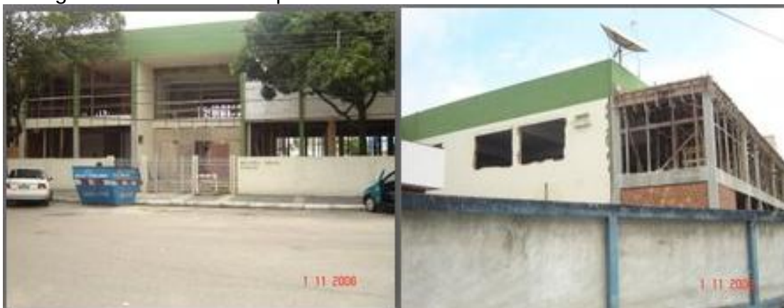
Fotografia 4 - Reforma do prédio da Biblioteca - 2006
