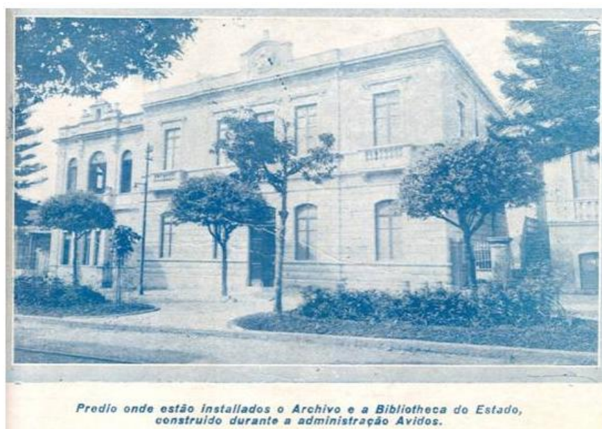
Figura 4 - Prédio do Arquivo e Biblioteca - 1926
