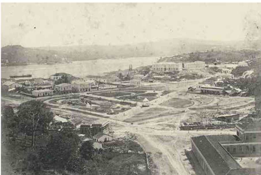
Vistas panorâmicas abrangendo o Quartel da Polícia, remodelado, o conjunto de casas recém-construídas, os novos pavilhões da Santa Casa de Misericórdia e, ao centro, as obras do Parque Moscoso (1908-1912). APEES – Coleção Jerônimo Monteiro, 403.
