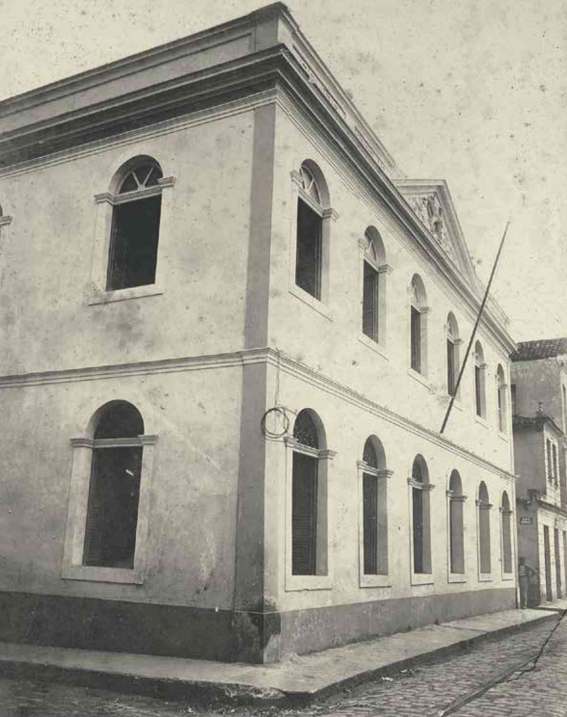
Prédio onde funcionou o Grupo Escolar Gomes Cardim na antiga rua Pereira Pinto, em Vitória (1911). APEES – Coleção Jerônimo Monteiro, 153.
