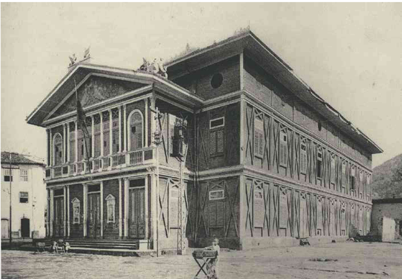
Teatro Melpômene, construído em 1896, no governo de Moniz Freire, pelo engenheiro italiano Filinto Santoro. APEES – Indicador Ilustrado (1910), 022.
