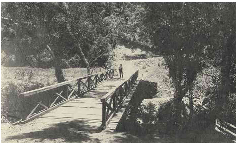
Ponte sobre o rio Novo no trecho da estrada de rodagem de Cachoeiro de Itapemirim a Rio Novo (1908). APEES – Coleção Jerônimo Monteiro, 271.
