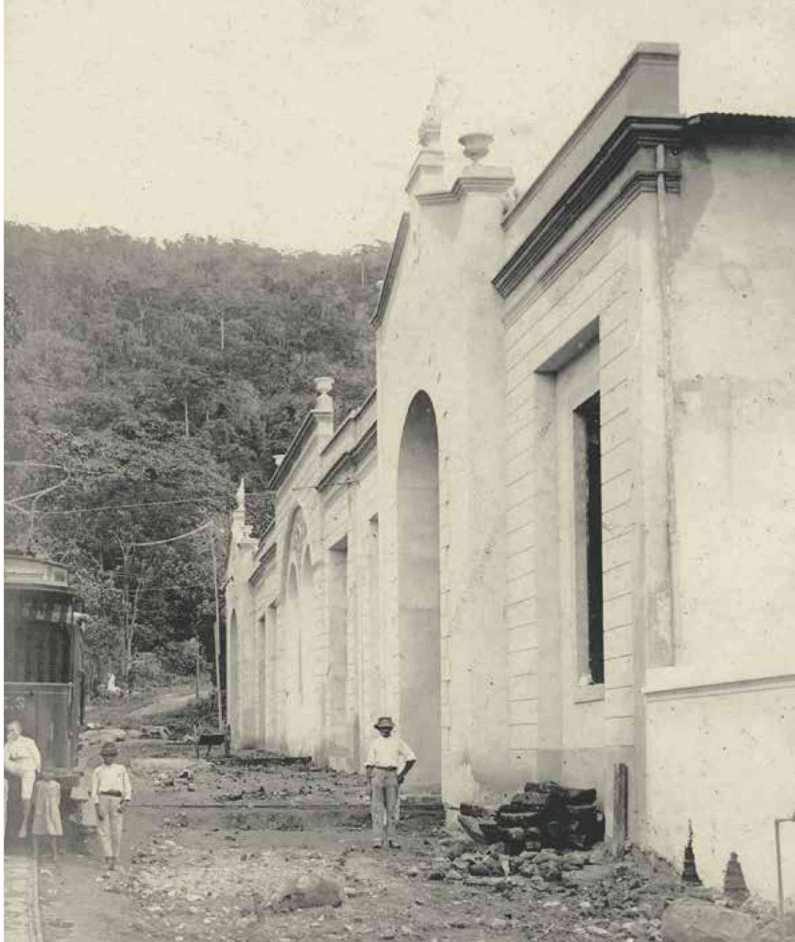
Edifício da Convertedora, estação de processamento de força elétrica. Imóvel construído em 1911, junto ao morro da Fonte Grande, e que também serviu como garagem e mecânica de manutenção dos bondes da capital. No local, encontra-se instalada, atualmente, a sede do Arquivo Público do Estado do Espírito Santo (1911). APEES – Coleção Jerônimo Monteiro, 332.
