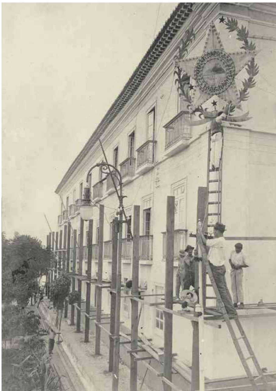
Instalação de andaimes em uma das fachadas do palácio para o início das obras de remodelação da sede do governo estadual (1911). APEES – Coleção Jerônimo Monteiro, 020.
