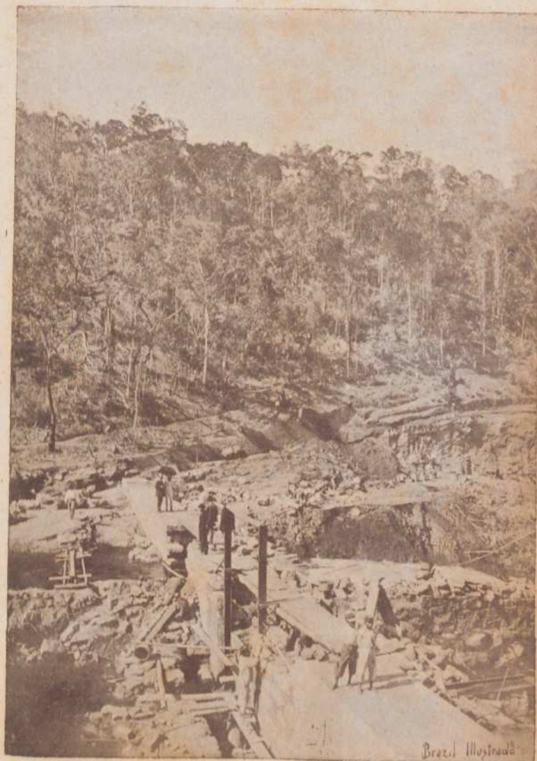
A muralha com o rio Jucú desviado para a construcção da porta
