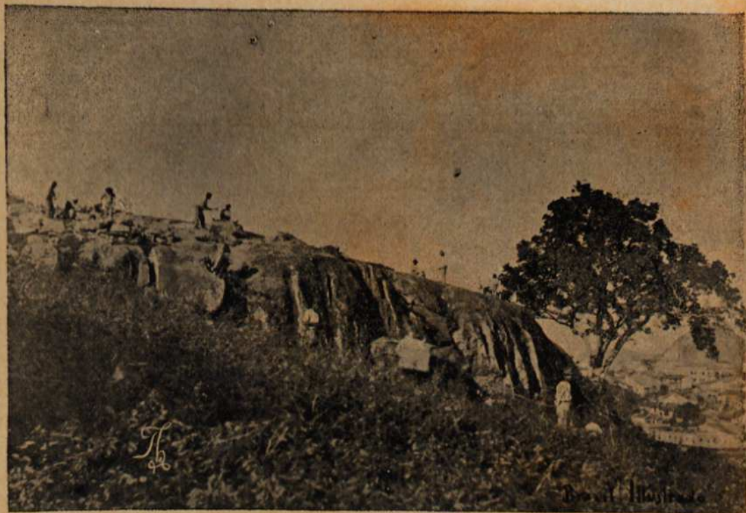
Morro da Lapa no Campinho onde está sendo construida a sub-estação da energia electrica
