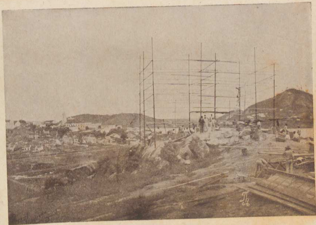
Andaime para a uzina no morro de S. Clara = Visto do alto.
