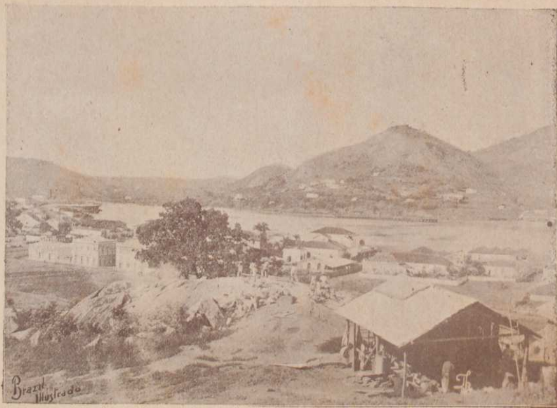
Pedreira onde vae ser construida a uzina electrica distribuidora = Vista do alto
