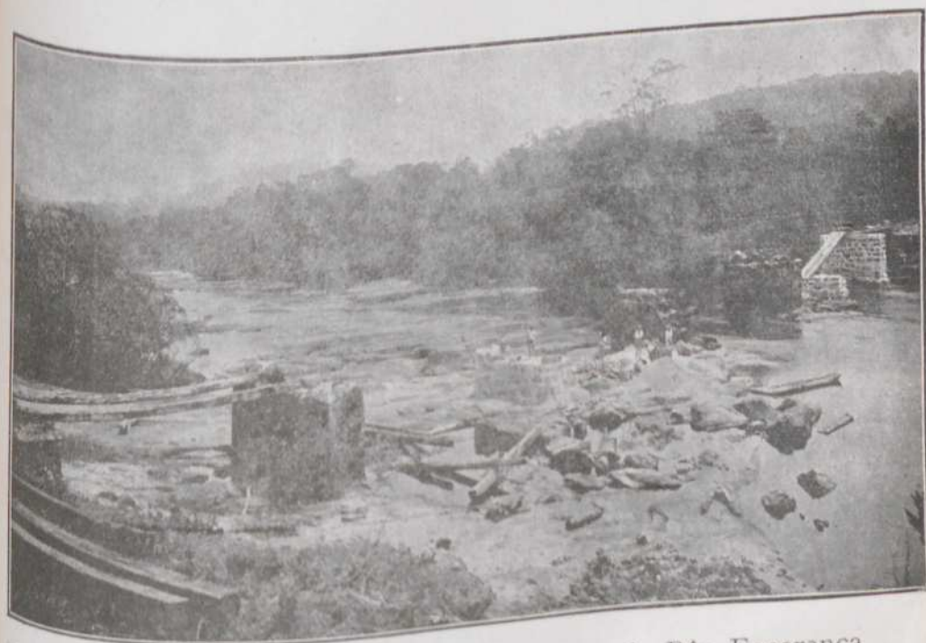
Itapemirim — Reconstrucção da ponte de Bôa Esperança Município de Cachoeiro de Itapemirim
