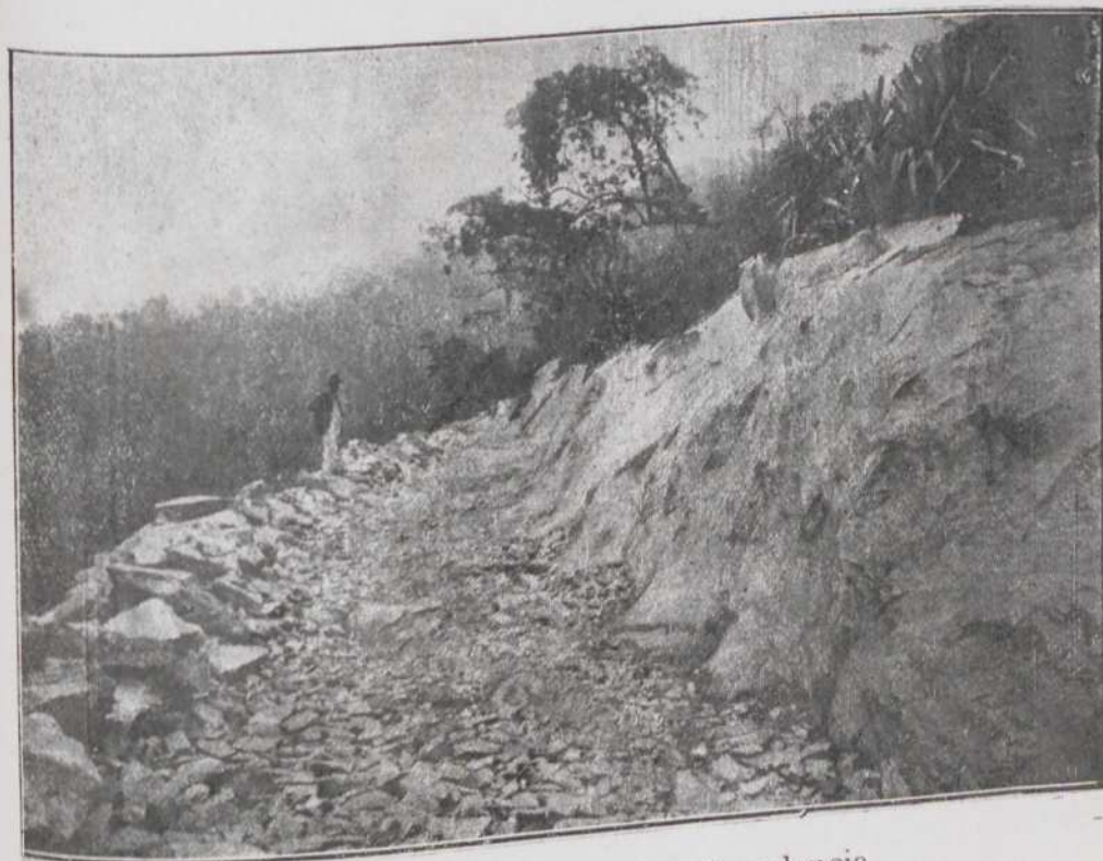
Corte na Pedreira da Abundancia
