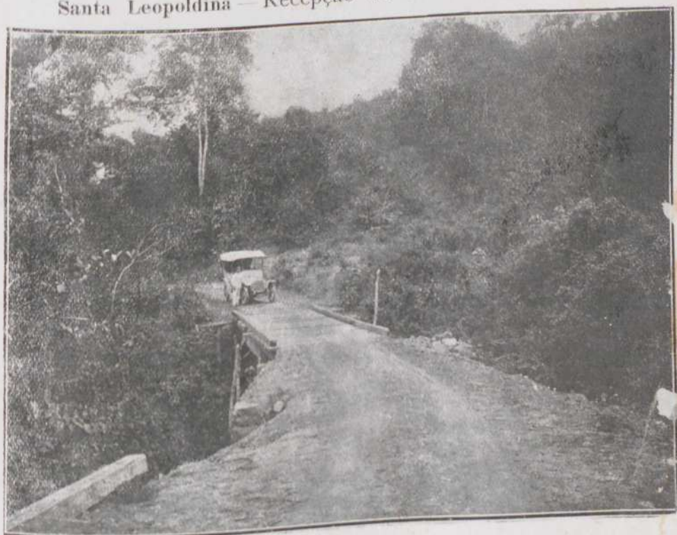
Trecho da estrada de rodagem de Santa Leopoldina a Alfredo Maia — Porto Conceição
