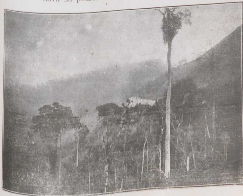
Corte na pedreira da Abundancia visto de longe
