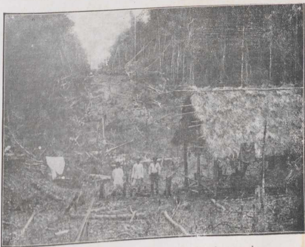
Picadão aberto, para a construção da estrada Linhares a Cavallinhos
