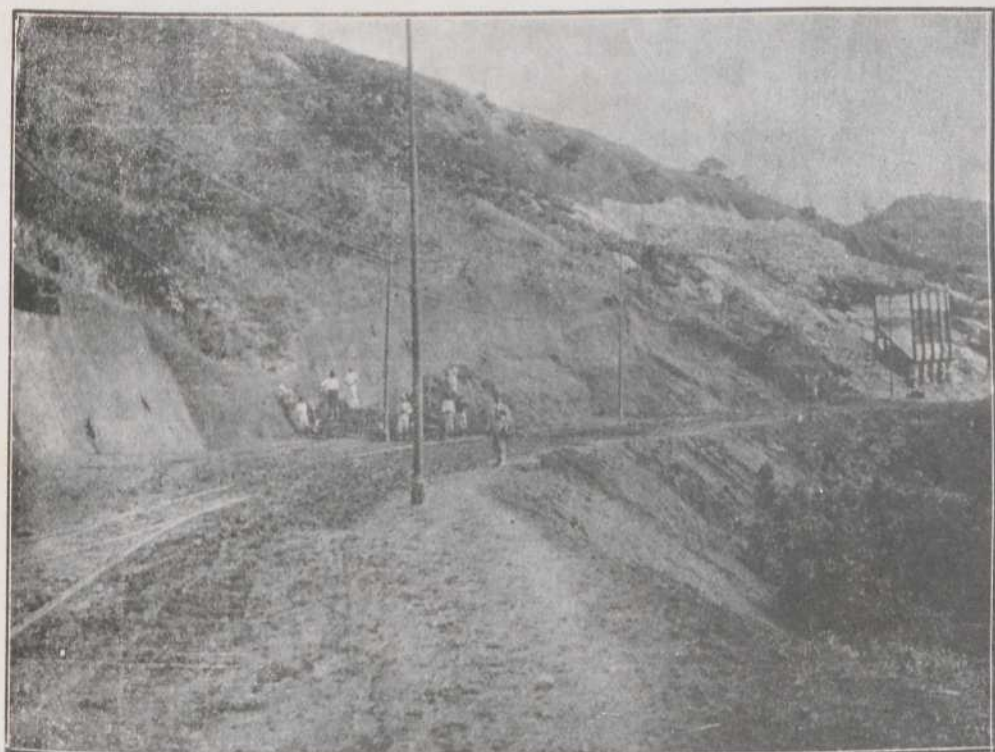
Estrada de automoveis para a Praia Comprida. Trecho em construcção no Forte de S. João. Corte e britador para macadamisação da estrada
