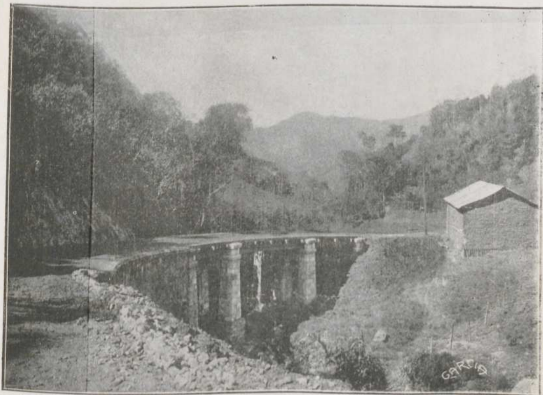
Santa Thereza — Viaducto Scapardini
