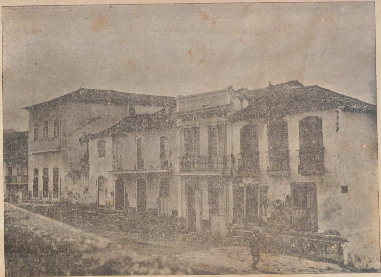
A praça João Climaco, antes das obras effectuadas
