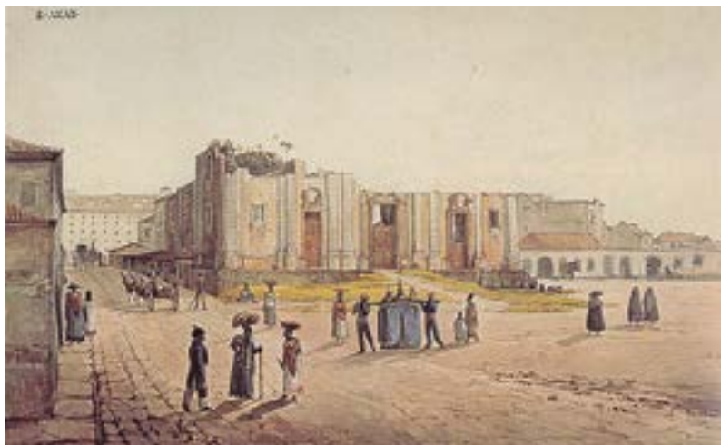
Com a chegada das Missões Francesas diversas construções começaram a tomar forma buscando dar suporte a esse novo espírito cultural, entre elas a Escola Real de Ciências, Artes e Ofícios. Construção incompleta da Academia de Pintura . Thomas Ender, 1817.
